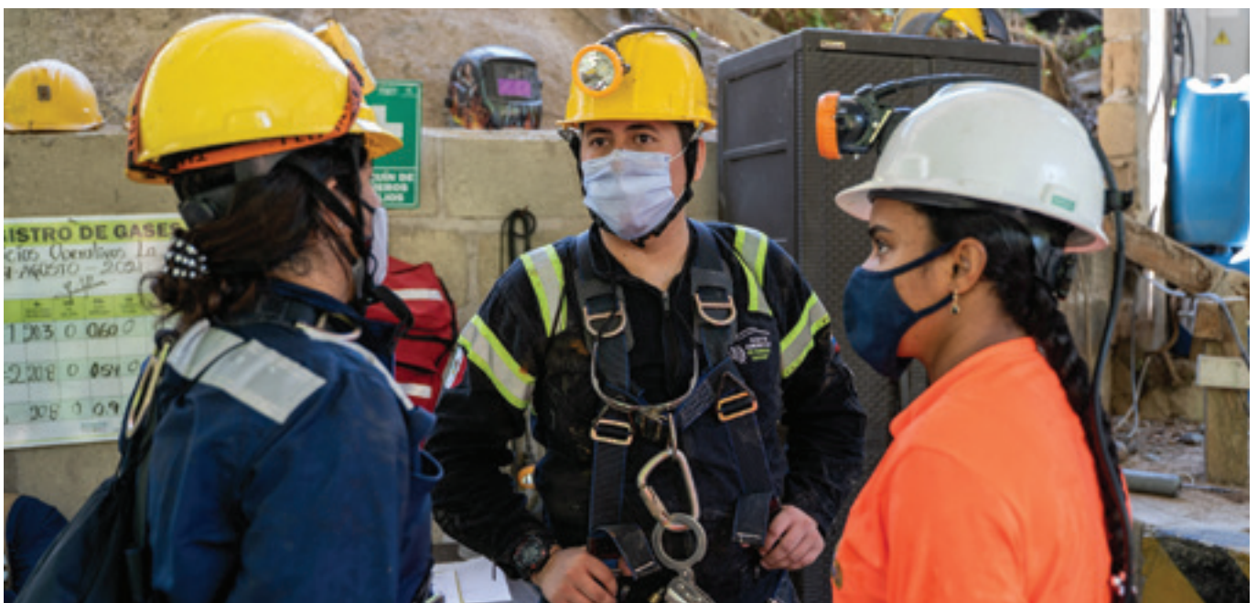
Conseils sur les points d’ancrage pour les travaux en hauteur aux unités de production minière de La Maria SAS, Colombie. Droit d’auteur : B2Gold
